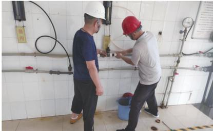
但是大家没有丝毫退缩。没有图纸，大家共同想办法，在白纸上画个草图，配件不合适，大家就打磨的打磨，切割的切割，拆卸的拆卸，经过一整天的辛勤努力，终于将两套加氯管道系统改造完成，经过调试，运行效果良好。
