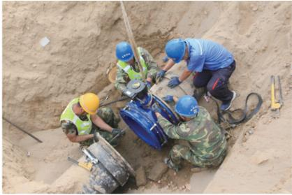
为解决灵武市长期以来水源单一、没有后备水源问题，由灵武市水务局牵头，灵武供水公司和宁煤水电公司配合，连接大泉水源地DN600配水管线。经过实地勘探，最终选择在东山加压站进行连接。
